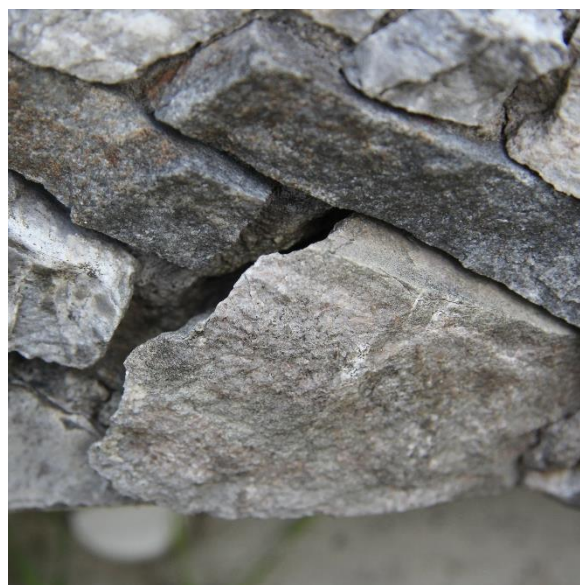
Obr. 12: Detail poškození mozaiky – ukázka uvolněných mozaikových kamenů.
