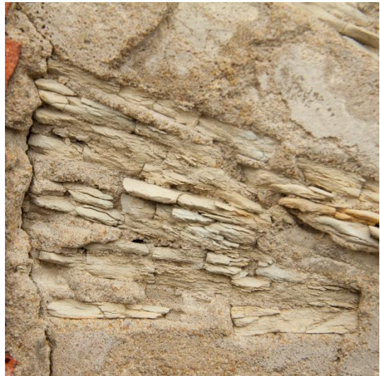
Obr. 3: Detail mozaiky – zvětvávání opukových kamenů osazených kolmo k maltovému loži.
